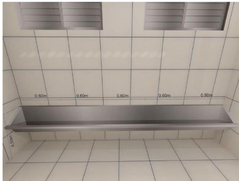
Figura 2: Padrão desejável de instalação de mictório tipo calha
